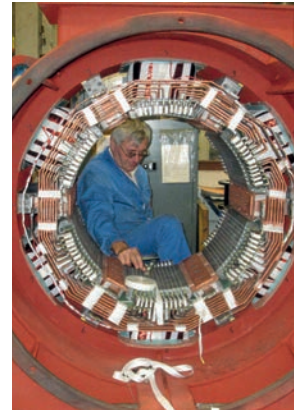
Omlindning av 1 MW DC-motor, Stora Enso.
