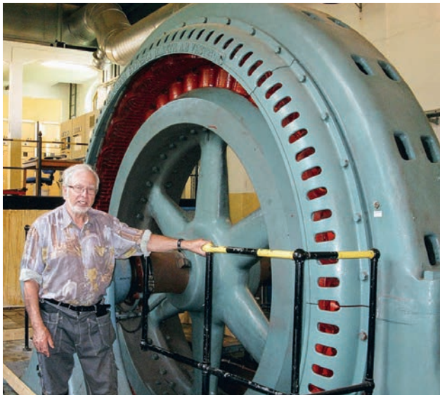
Omlindning av vattenkraftgenerator.
