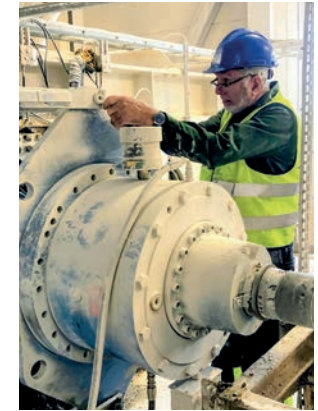
Uppmätning av växellåda för utbyte. Nordkalk.
